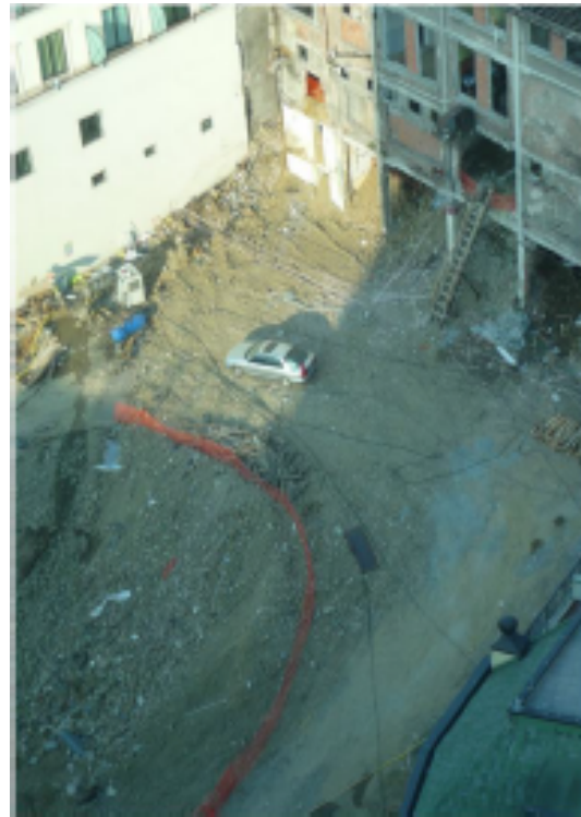
Figure 1.2. Une fouille en Turquie sur un chantier de construction. Notez que les parois de l'excavation sont trop raides et ne pas avoir la délocalisation pour maintenir la pente stable.
