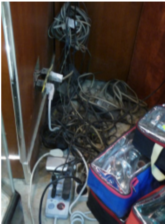
Figure 2.3 : Beaucoup de prises électriques mises dans peu de prises de courant. Ces câbles et prises électriques dans un magasin en Égypte sont dangereusement surchargés. La prise murale est mal câblée. Cette situation est susceptible de provoquer un incendie.
