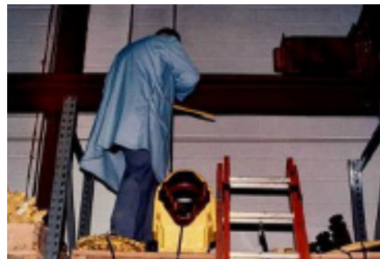
Figure 2.2: Ce travailleur est complètement non protégé, il se trouve sur une plate-forme surélevée sans garde-corps, l'échelle est aussi trop courte et il y a un encombrement au niveau de la passerelle, il peut alors facilement trébucher et tomber sur le sol en béton au dessous de lui. S'il tombe directement sur sa tête d'une telle hauteur, le dommage cérébral qui peut en résulter pourrait causer une invalidité permanente. (Crédit photo, Julietta Rodríguez-Guzman, Universidad El Bosque.)
